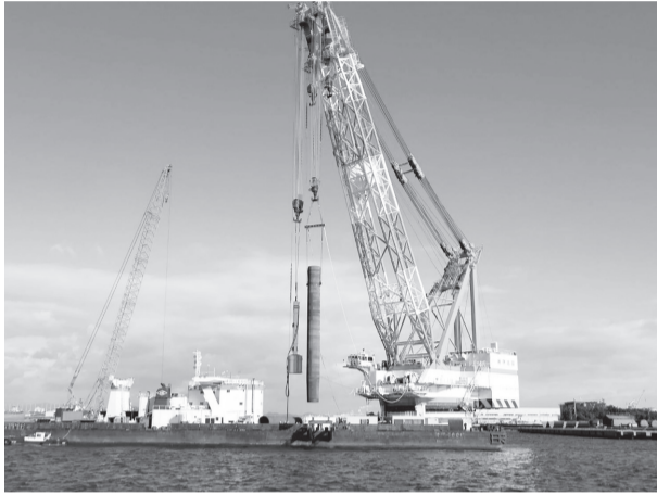
テーパー杭の海上打設実証試験（令和元年12月、東播磨港）
